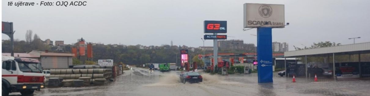
Figura 18. Nëntor 2025: Hyrja në Mitrovicë, zona industriale (ish-FAFOS) – praktikë e dobët e menaxhimit të rrjedhjes sipërfaqësore të ujërave - Foto: OJQ ACDC
